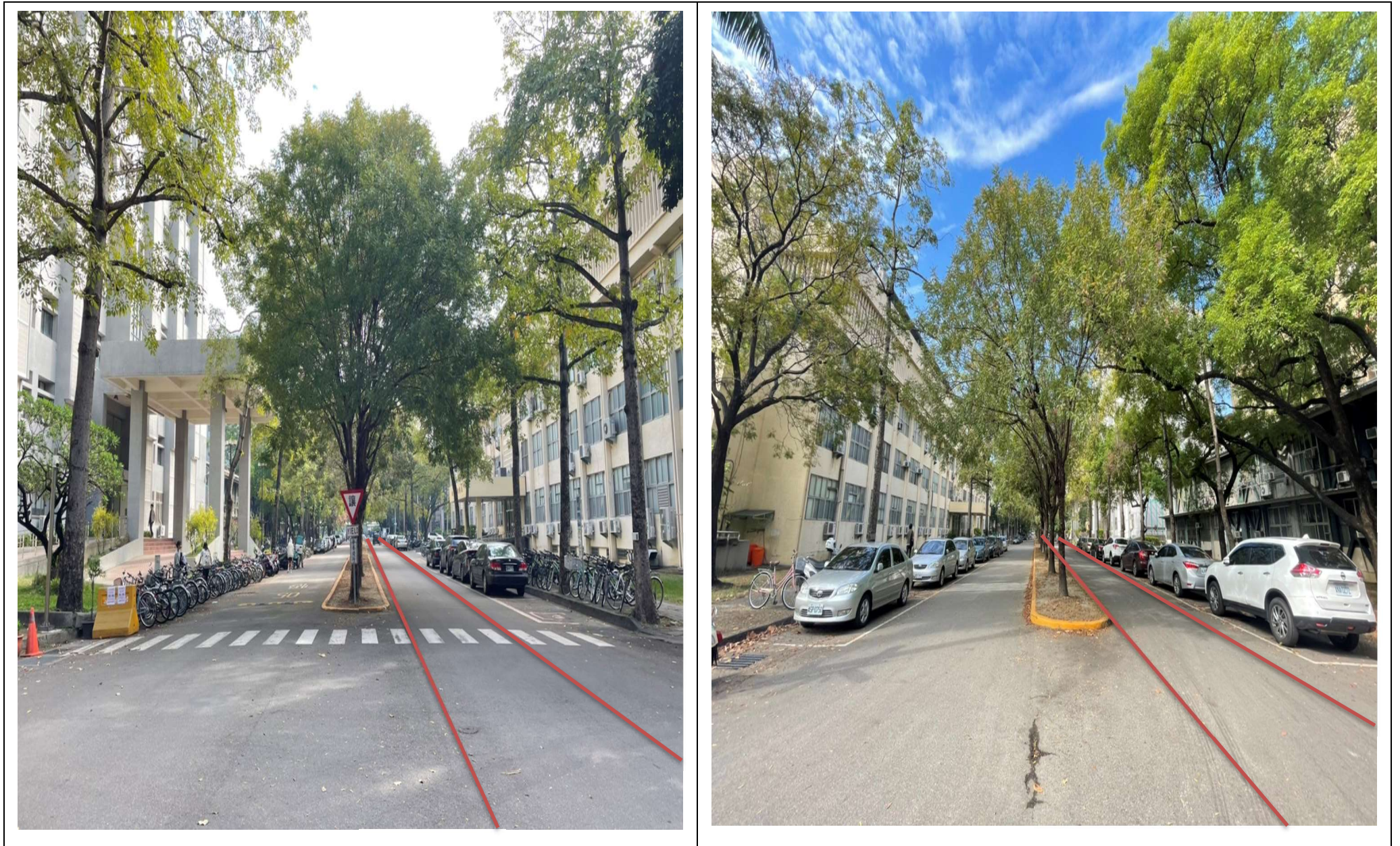
【校區污水下水道(含建物接管)及弱電共同管路建置工程施工範圍及位置圖】
