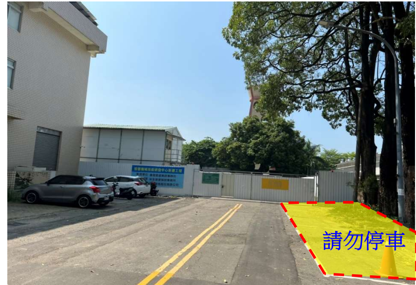
【智慧機械技術研發中心新建工程地樑混凝土澆置作業施工區域現場照片】
