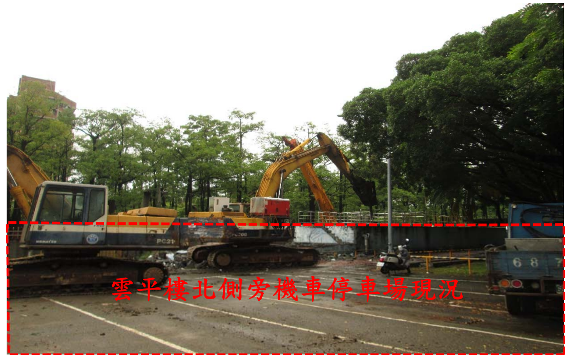
【雲平樓北側旁機車停車場地坪鋪面改善施工位置現況】
