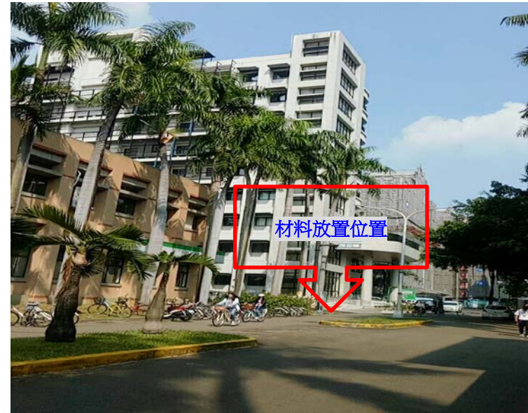
【食安大樓施工位置地現況】
