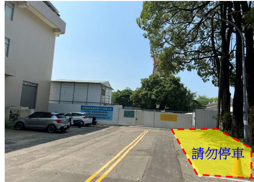
【智慧機械技術研發中心新建工程混凝土澆置作業施工區域現場照片】
