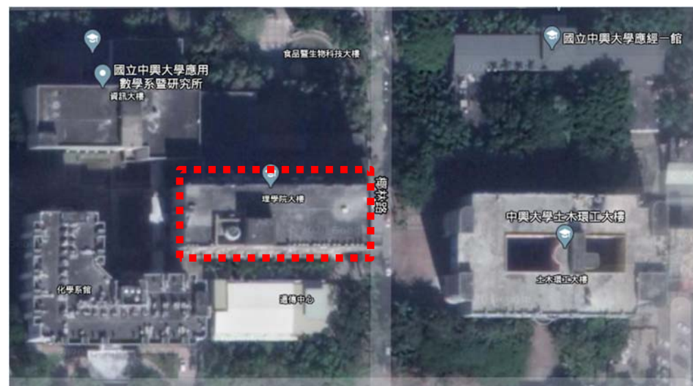
【理學大樓一樓 A03 施工位置空拍圖】
