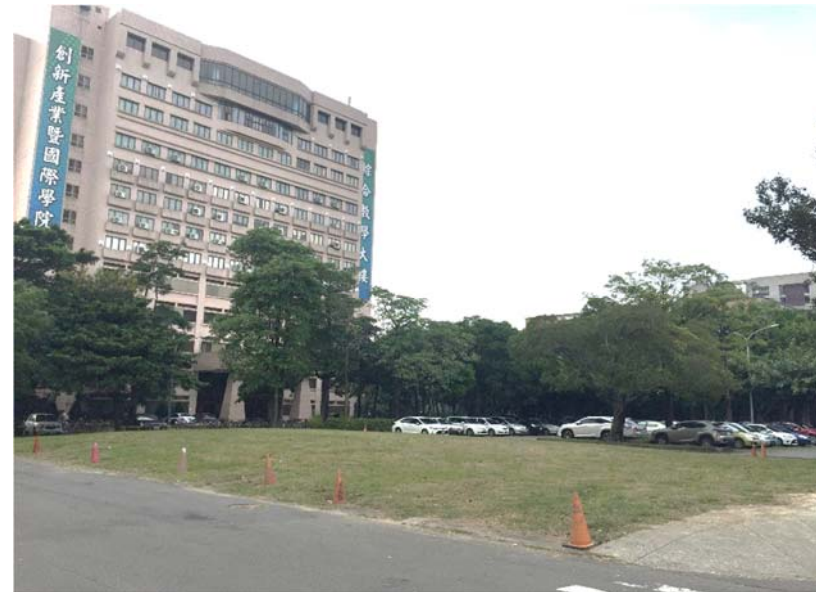
【第二餐廳地質鑽探工程地質鑽探工程現況位置】
