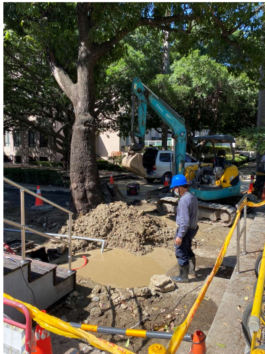
【圓廳北側地下水管線施工現場】
