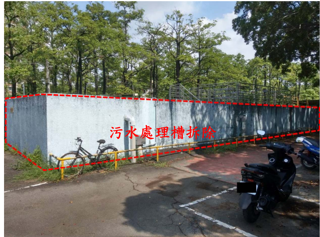
【社管大樓後方之污水處理槽拆除施工位置現況】
