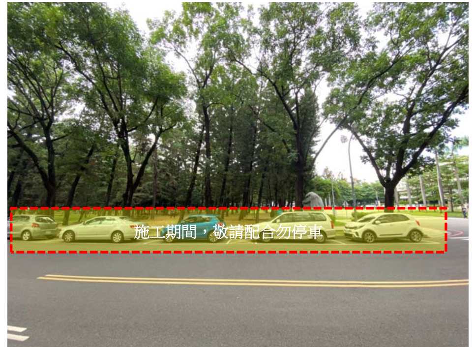
【行政大樓東側地下水管線施工處現況】
