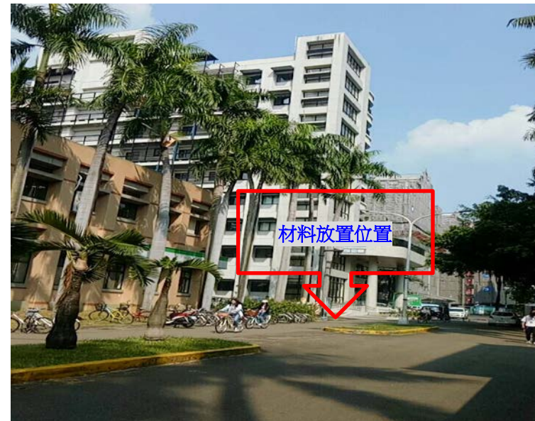
【食安大樓施工位置地現況】
