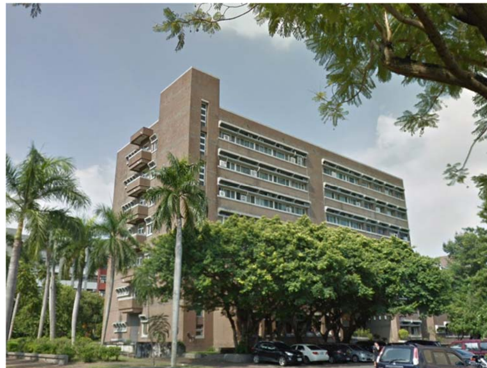
【生機大樓現況照片】
