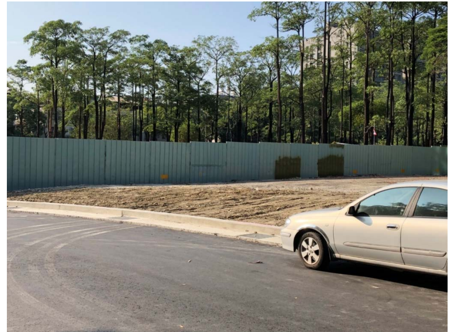
【西側一門施工位置現況】
