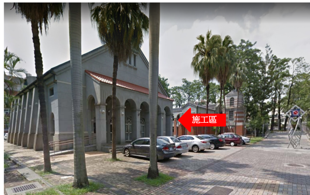
【小禮堂南側地下水管線施工處現況】
