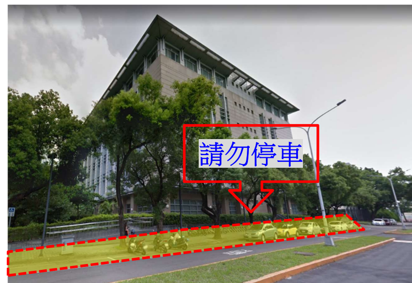
【圖書館綠能機房建置工程施工位置地現況】
