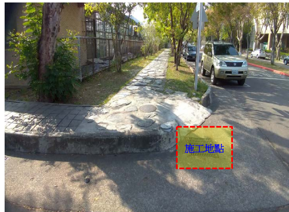
【溫室區地下水管線施工處現況示意】
