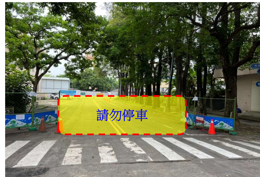
【智慧機械技術研發中心新建工程 1FL 混凝土澆置作業施工區域現場照片】
