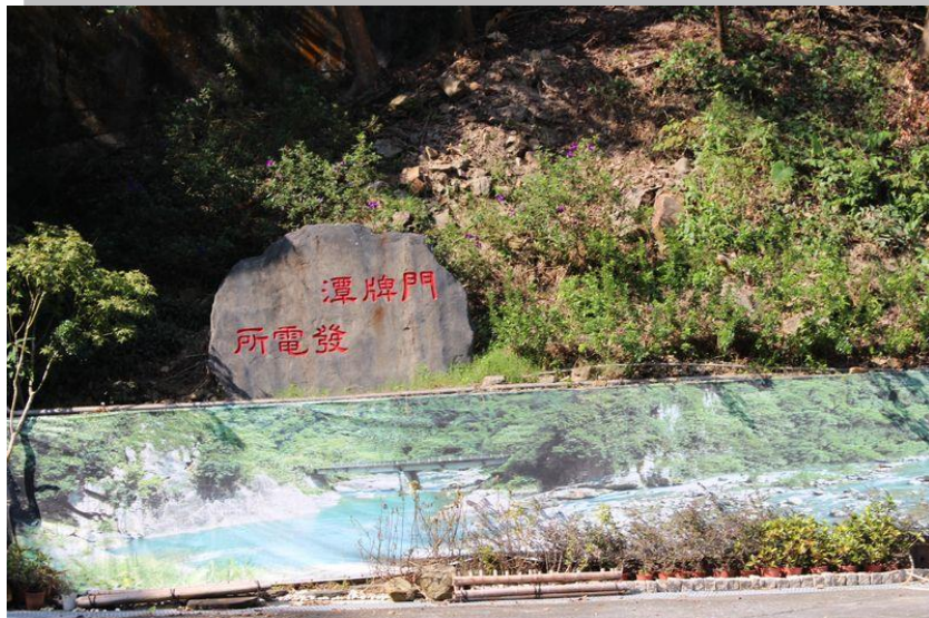
圖 8、大觀發電廠，舊名門牌潭發電廠，台語諧音像似墓牌潭，後改名為大觀。1918 年（日本大正 7 年）完工，二次大戰時曾遭美軍轟炸。1980 年增建大觀二廠，是一座抽蓄式的發電廠，白天利用日月潭的水發電，晚間則以多餘電力將水抽回潭中，循環使用。
