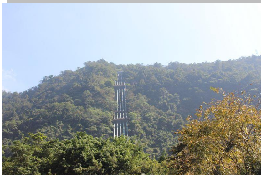
圖 9、山的背後即是日月潭，管線內的水傾洩而下推動發電機。
